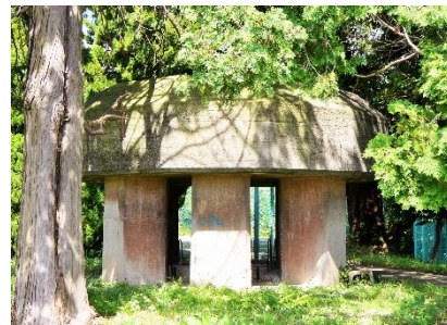
日吉台地下壕竪穴空気坑
