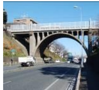
響橋(めがね橋)
